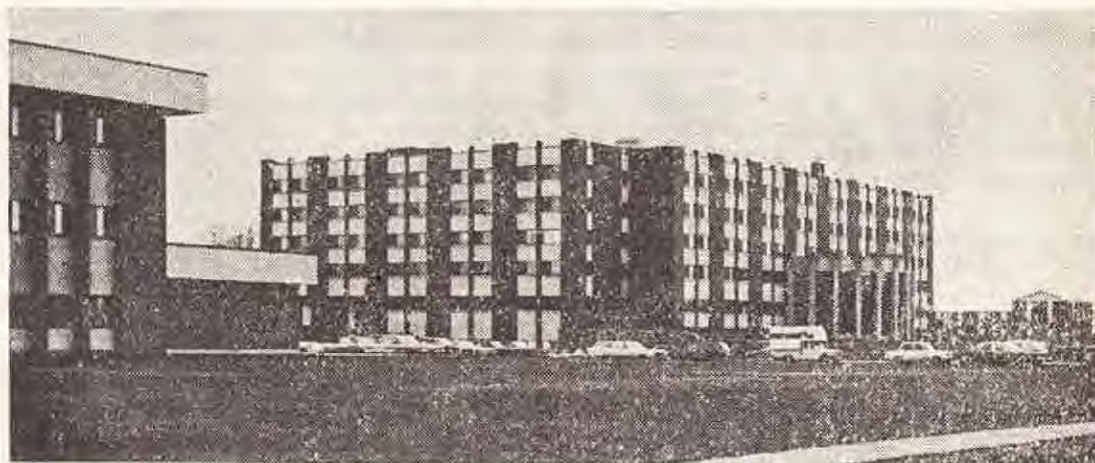
A la ferme de la Watchtower, le nouveau bâtiment résidentiel (au centre) relié à l'imprimerie, à gauche.
