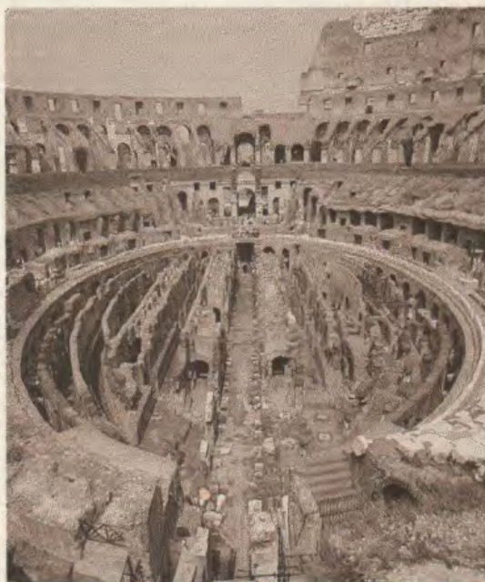
À l'intérieur du Colisée.
