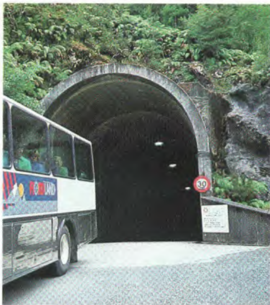
Tunnel d'accès et descente vers la salle des machines
