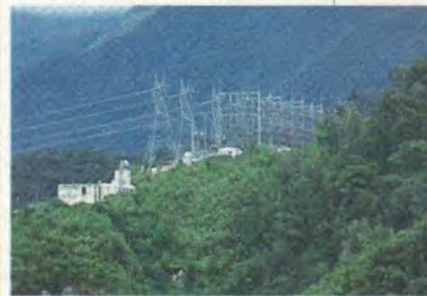
▲ Centrale électrique de Manapouri
