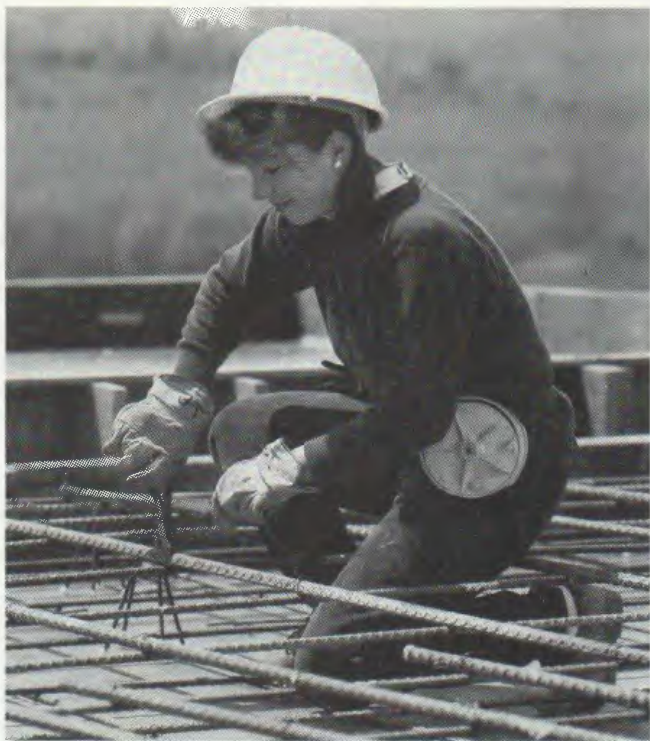
Ligaturer le fer à béton: une partie du travail de construction.
