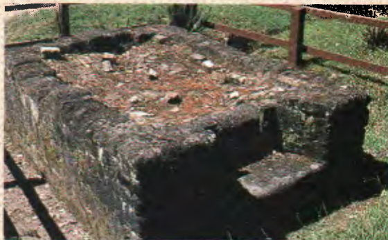
Restes d'un four à pain détruit en 1886.
